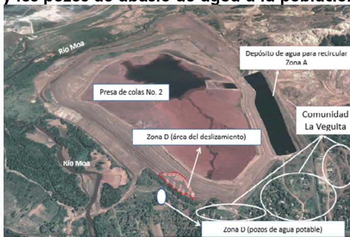
Figura 5. Ubicación de deslizamiento de la presa, la comunidad La Veguita y los pozos de abasto de agua a la población de Moa
