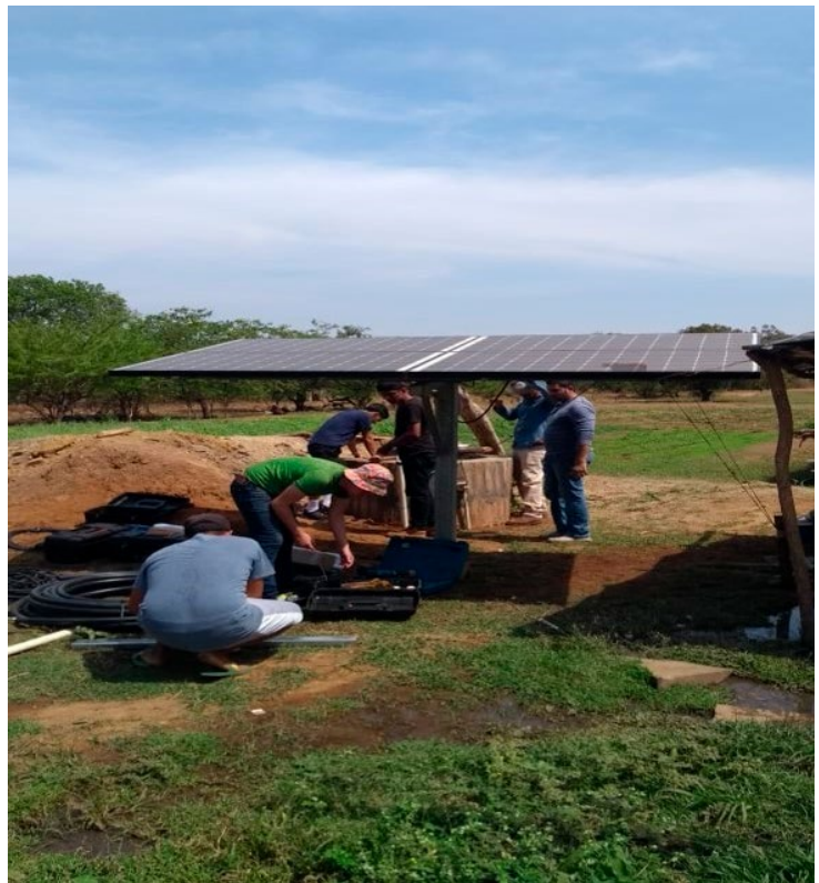
Figura 7. Instalación sistema de bombeo solar fotovoltaico. ENICALSA. Fuente: Br. Víctor Ruiz.
