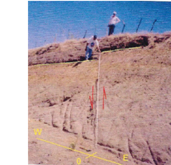
(a) Curvas de resistividad aparente y de campo magnético total (b) Curvas VLF Componente Real y componente Imaginaria (c) Vista hacia el Norte carretera Nueva a León. Falla en estación O.
