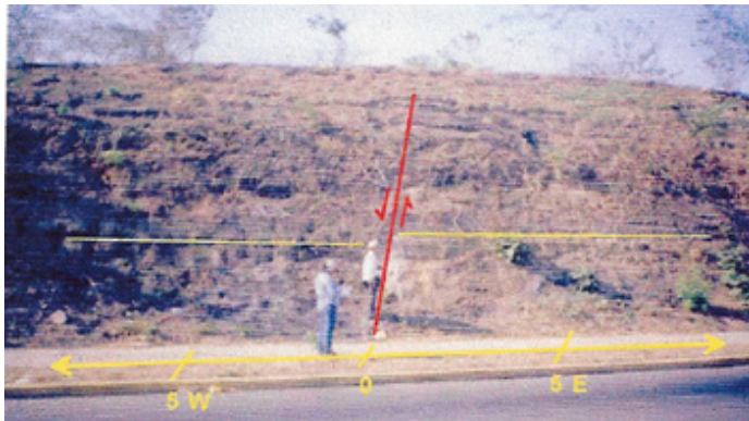
(a) Curvas de resistividad aparente y de campo magnético total. (b) Curvas VLF Componente Real y componente Imaginaria. (c) Vista hacia el Norte Pista Suburbana. Falla en estación O.
